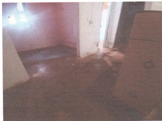
Figura 8 – Revestimento: piso cimentício
