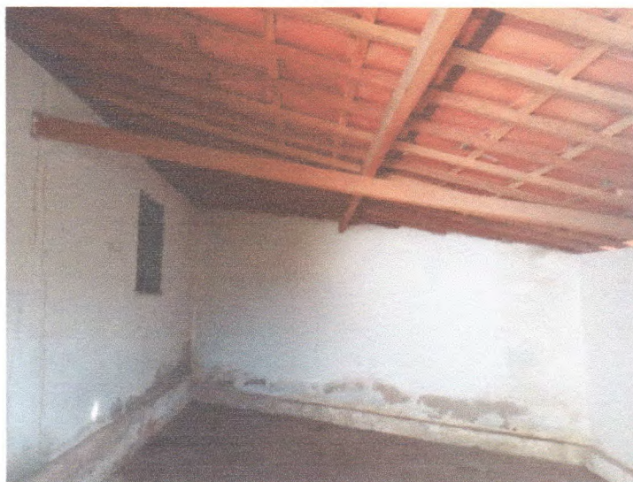
Figura 3 – Caibros e ripas apoiados nas paredes
