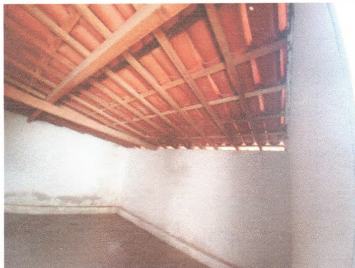
Figura 2 – Estrutura da casa
