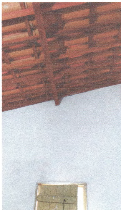
Figura 3 – Paredes de sustentação do telhado
