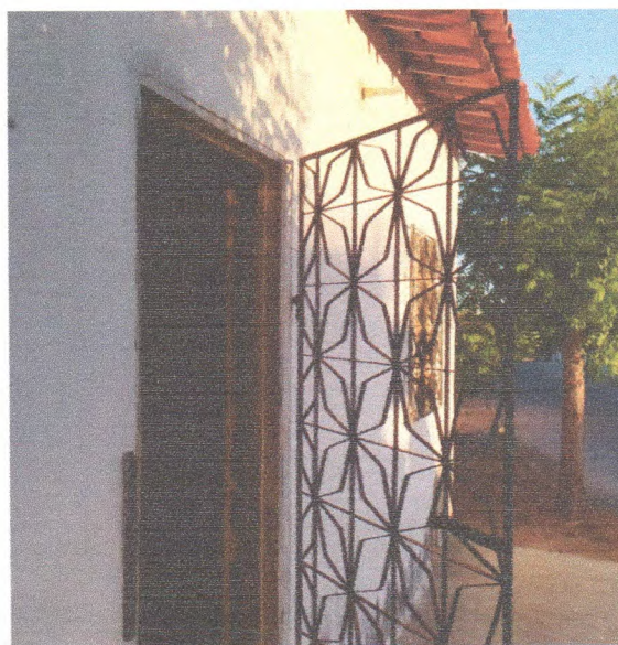
Figura 16 – Portão de entrada
