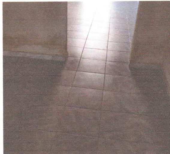
Figura 9 – Piso cerâmico da sala e cozinha
