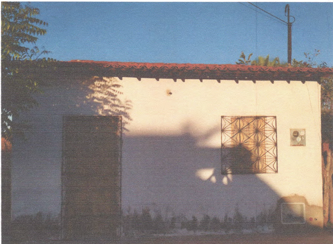
LAUDO TÉCNICO – PRÉDIO PARA ALUGUEL SOCIAL NO DISTRITO DE SUCESSO PELA PREFEITURA MUNICIPAL DE TAMBORIL-CE
