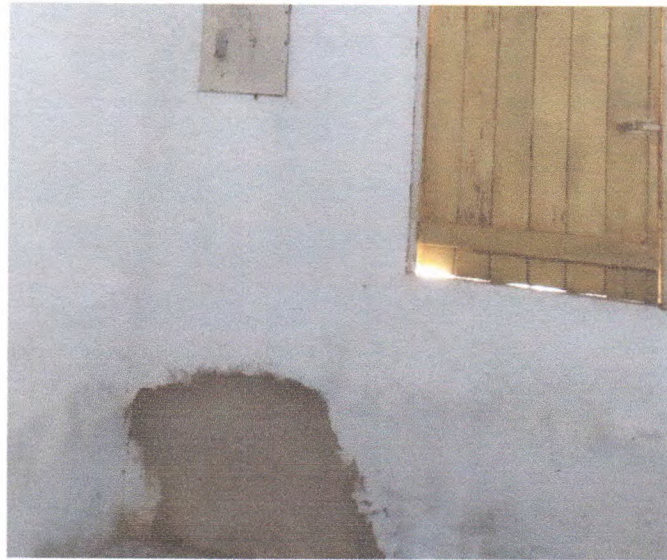
Figura 6 – Revestimento cimentício de reparo em parede
