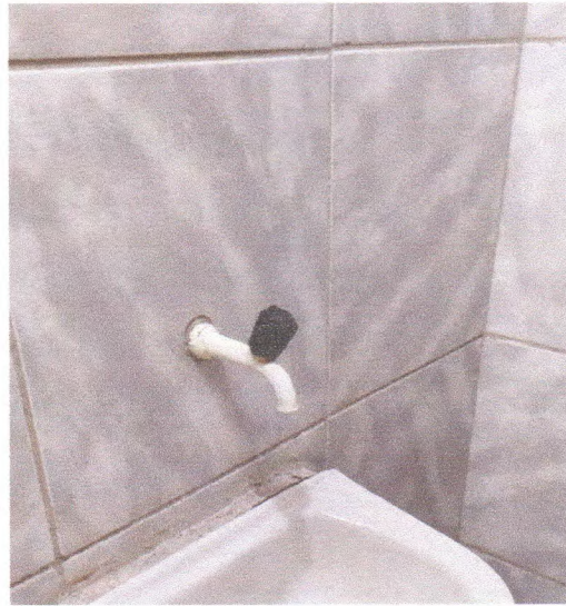
Figura 11 – Revestimento cerâmico do banheiro
