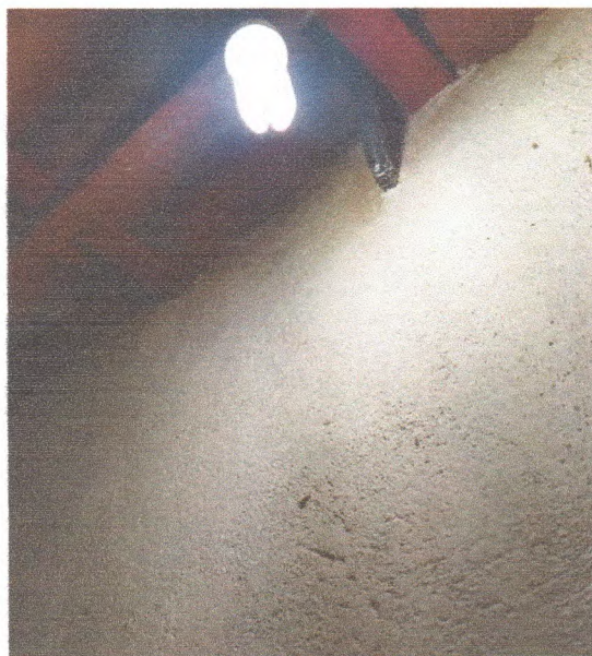
Figura 15 – Ponto iluminação do banheiro
