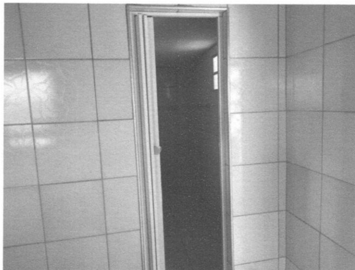
Figura 10– Esquadrias: porta do banheiro
