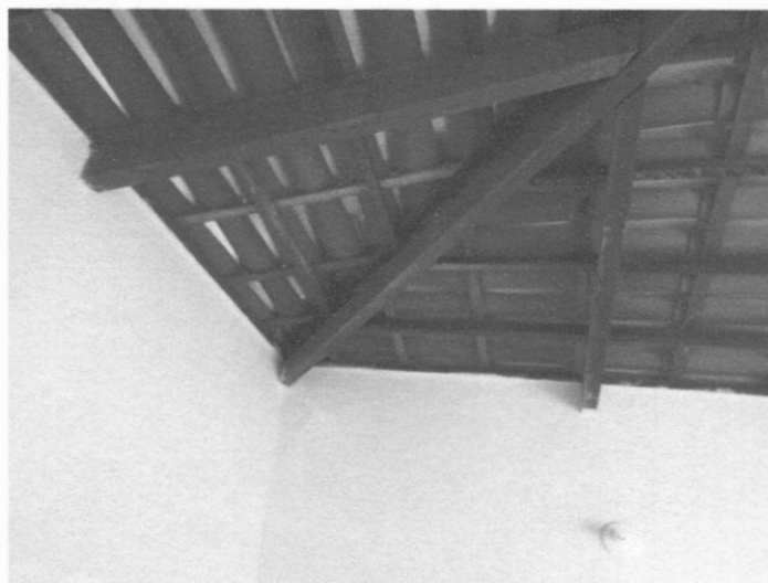
Figura 3 – Caibros e ripas apoiados nas paredes
