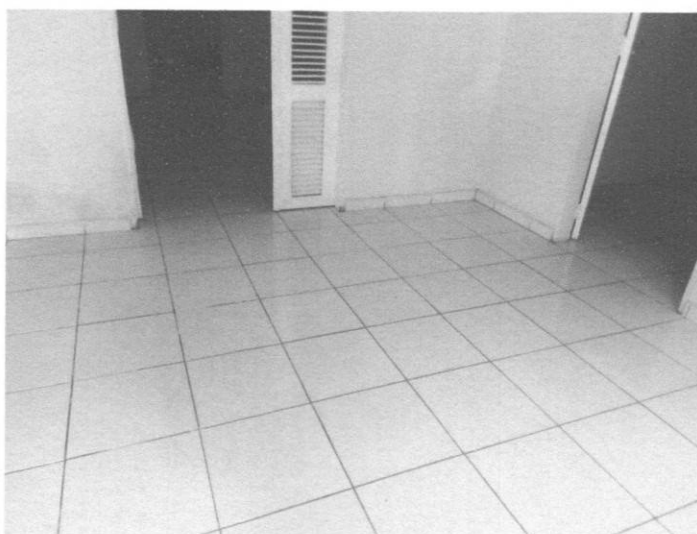
Figura 6 – Revestimento cerâmico completo
