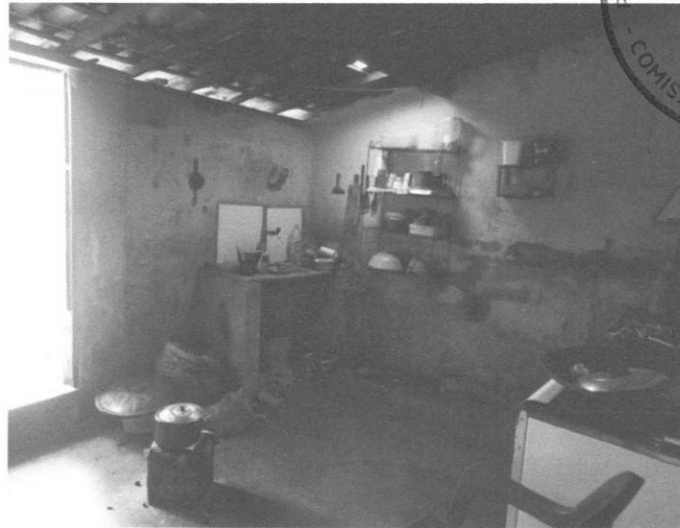
Figura 7 – Revestimento da cozinha
