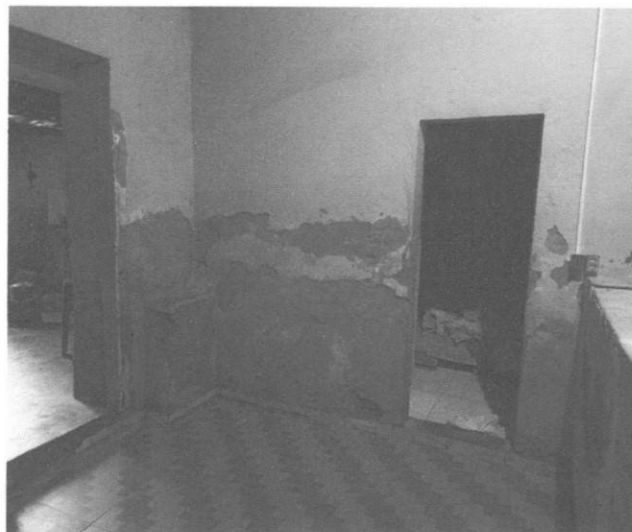
Figura 8 – Revestimento parede sala
