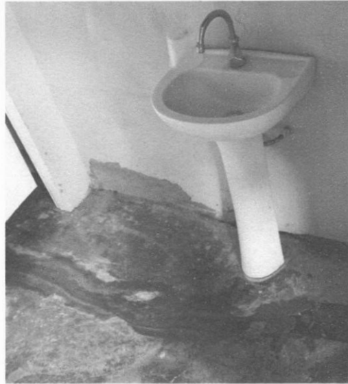
Figura 5 – Revestimento da parede do banheiro social deteriorado
