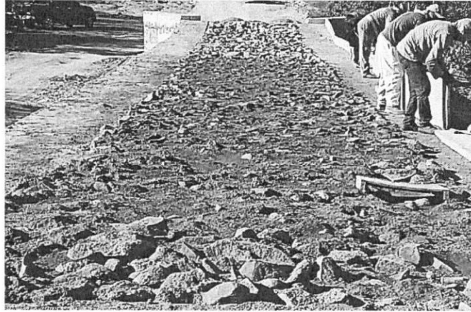
FOTO 03 – Pavimentação em pedra tosca, etapa anterior, a concretagem da laje
