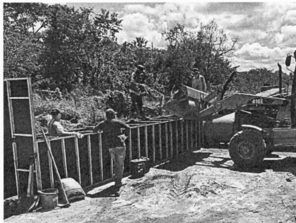
FOTO 02 – Execução das Alvenarias de Pedra Argamassada
