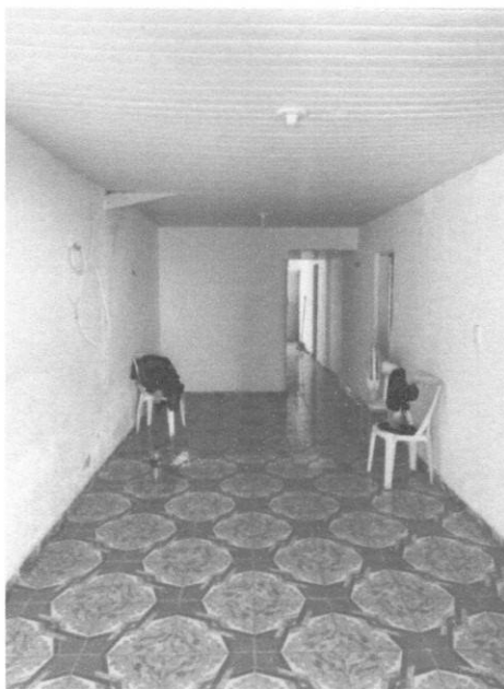
Figura 3 – Detalhes do teto
