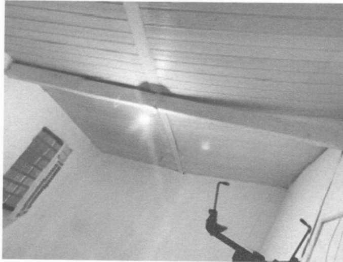
Figura 6 - Tomada e ponto de iluminação
