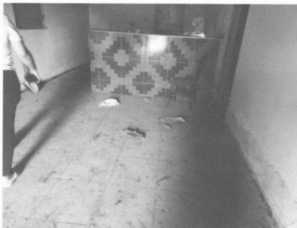
Figura 9 – Revestimento cerâmico completo
