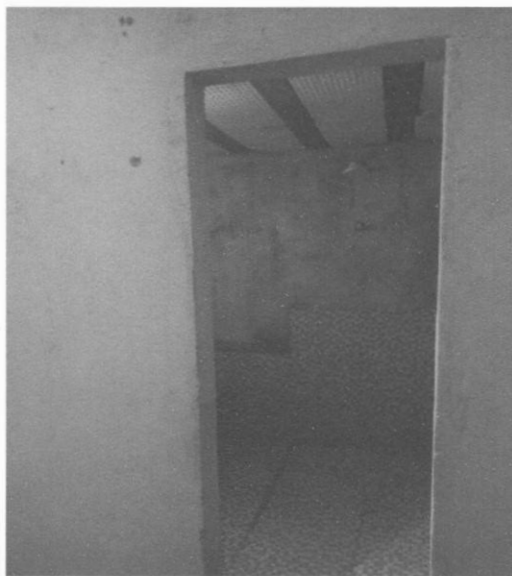
Figura 15 – Instalações hidrossanitárias: banheiro
