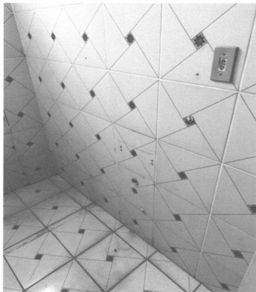
Figura 9 – Ponto de interruptor
