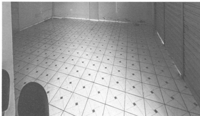
Figura 7 - Revestimento piso cerâmico por completo na edificação
