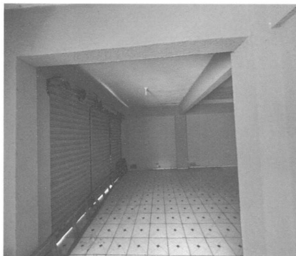
Figura 12– Portão metálico de entrada
