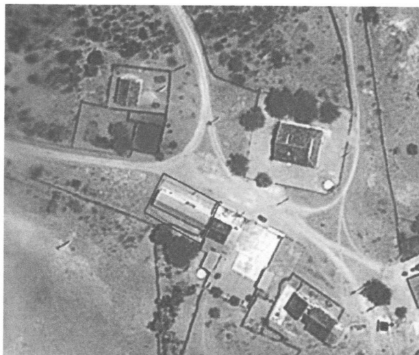
Figura 1: - Vista aérea da edificação.
