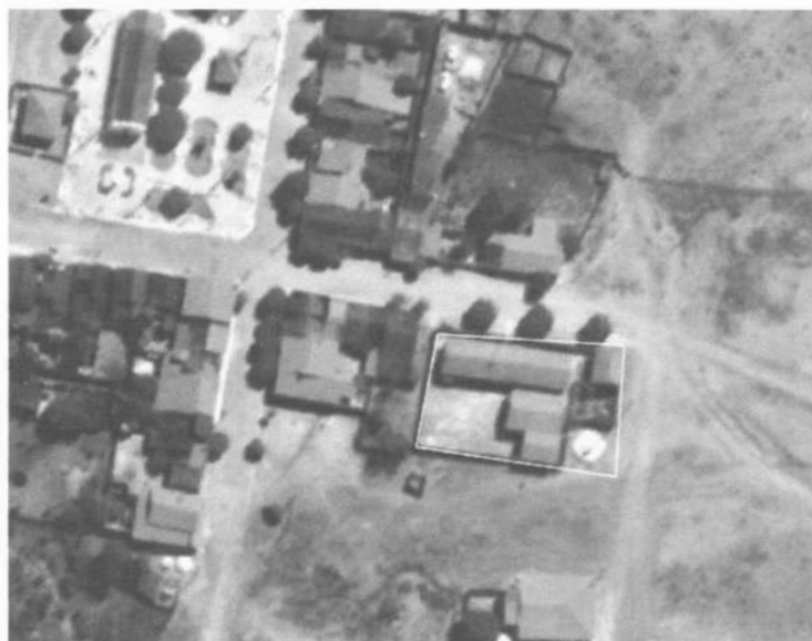
Figura 1: - Vista aérea da edificação.
