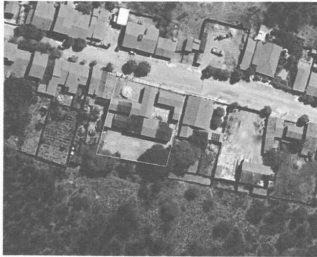
Figura 1: - Vista aérea da edificação.
