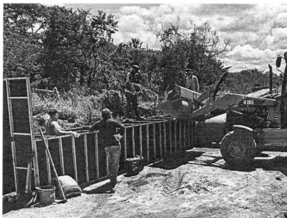
FOTO 02 – Execução das Alvenarias de Pedra Argamassada
