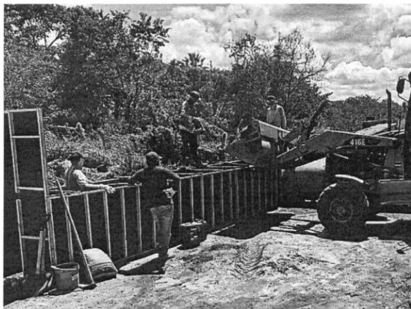
FOTO 02 – Execução das Alvenarias de Pedra Argamassada
