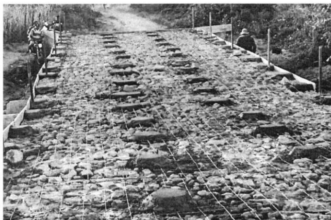
FOTO 04 – Execução de malha de aço
