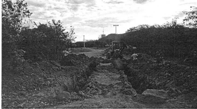
FOTO 01 – Escavação mecanizada.
