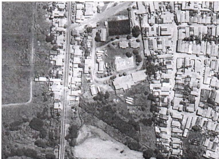
Figura 1: - Vista aérea da edificação.
