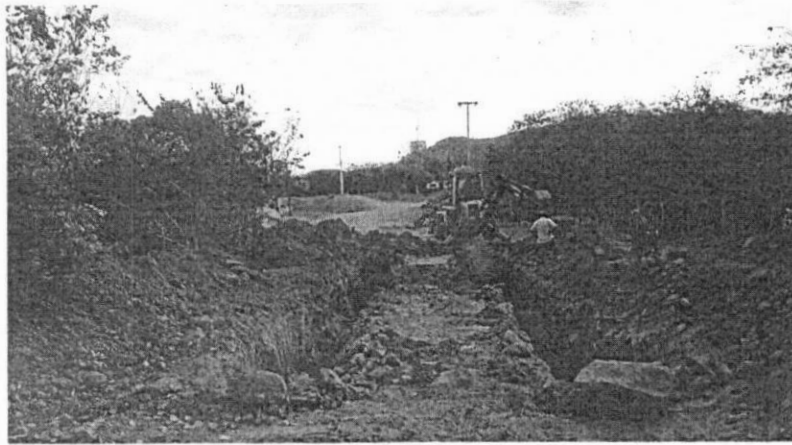
FOTO 01 – Escavação mecanizada.
