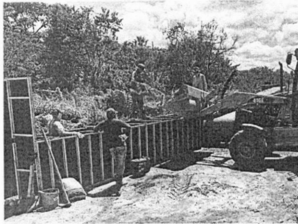
FOTO 02 – Execução das Alvenarias de Pedra Argamassada
