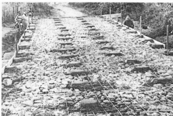
FOTO 04 – Execução de malha de aço
