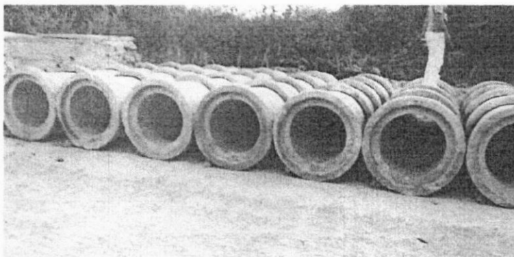
FOTO 04 – Assentamento de Manilhas de Concreto
