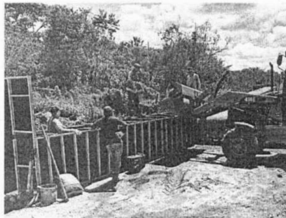
FOTO 02 – Execução das Alvenarias de Pedra Argamassada
