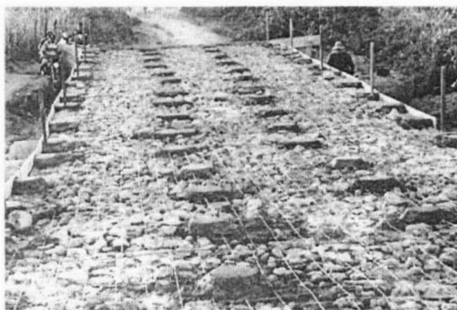
FOTO 04 – Execução de malha de aço
