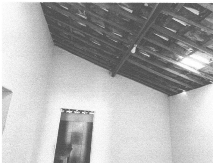
Figura 3 – Paredes de sustentação do telhado
