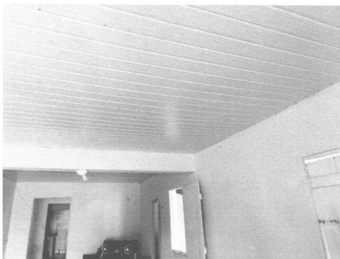
Figura 2 – Estrutura da casa
