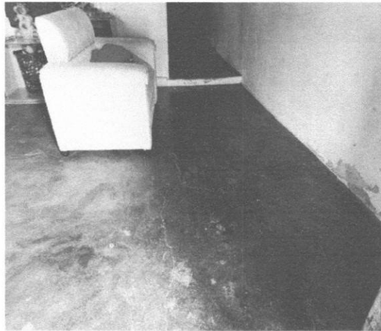
Figura 6 – Revestimento do piso
