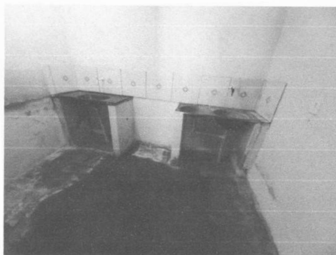
Figura 17 – Instalações hidrossanitárias cozinha
