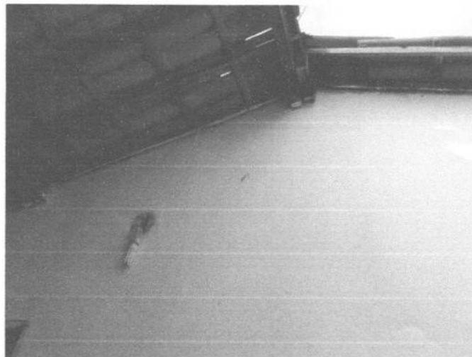
13 – Ponto de iluminação
