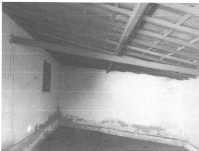
Figura 3- Caibros e ripas apoiados nas paredes
