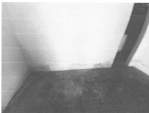
Figura 4 – Absorção de água pela viga baldrame
