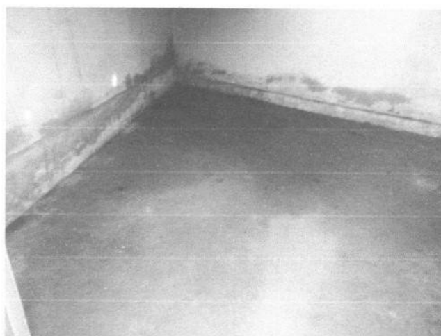
Figura 4 – Absorção de água pela viga baldrame
