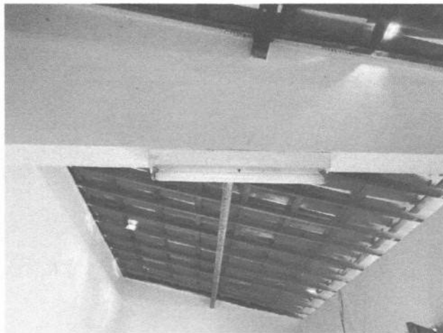
Figura 4 – Estrutura do prédio
