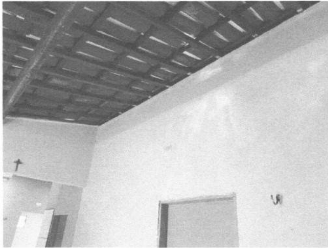
Figura 3 – Cobertura da edificação
