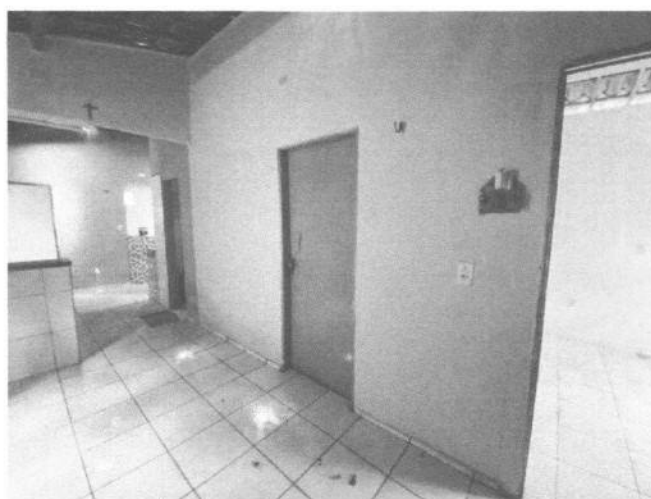
Figura 5 – Revestimento da parede
