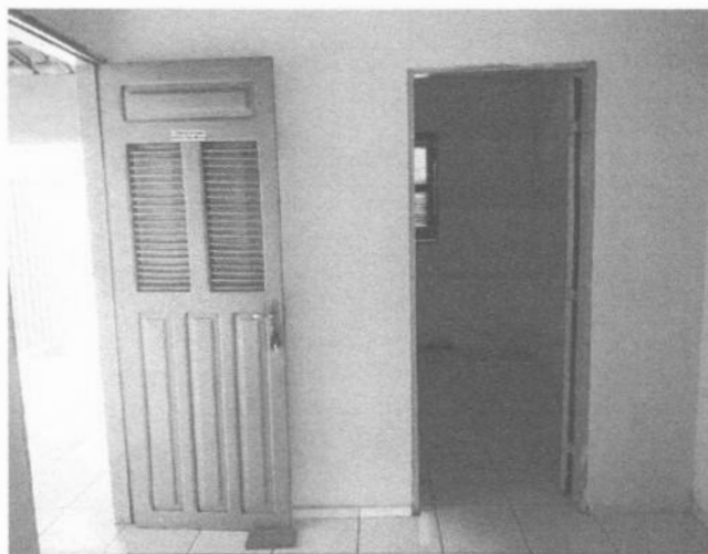
Figura 10 – Esquadrias de madeira
