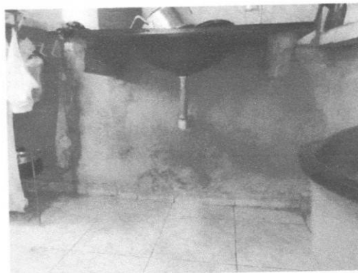
Figura 12 - Instalações hidrossanitárias cozinha
