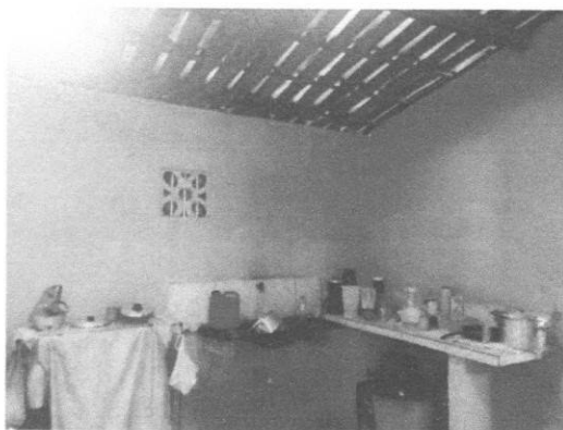
Figura 3 – Estrutura do prédio com telha colonial
