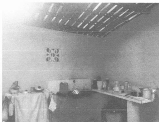
Figura 3 – Estrutura do prédio com telha colonial
