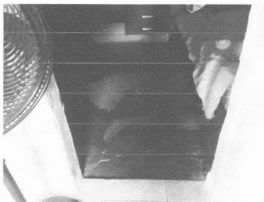
Figura 7 – Contrapiso de um dos cômodos
