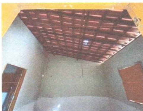
Figura 3 – Estrutura do prédio com telha colonial
