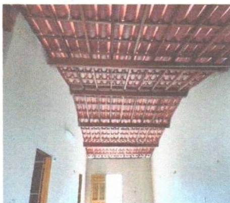
Figura 2 – Estrutura prédio com telha colonial
