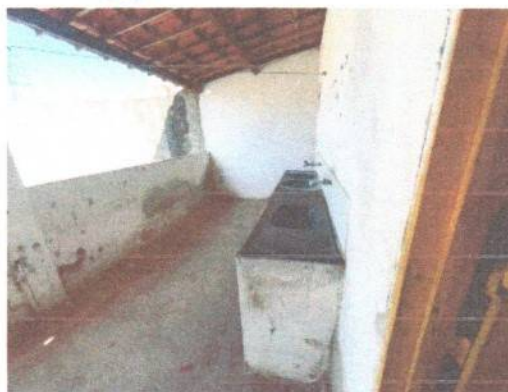
Figura 7 – Revestimento paredes da lavanderia
