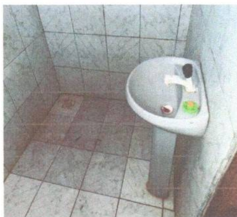
Figura 11 – Piso e revestimento cerâmico
