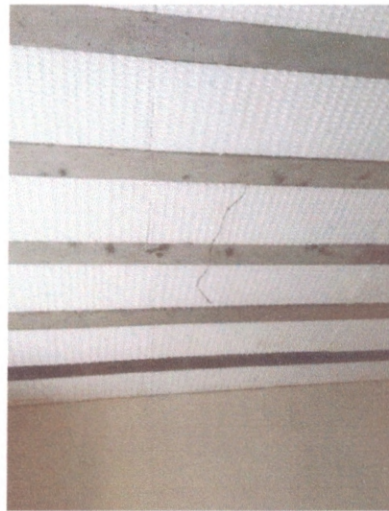
Figura 2 – laje em EPS
