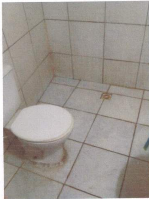
Figura 9 – piso do banheiro
