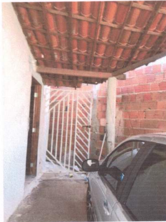
Figura 3 – Caibros e ripas apoiadas
