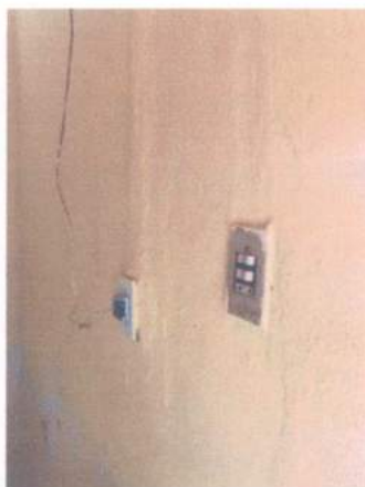
Figura 13 - Interruptor duplo e tomada/ tomada de telefone
