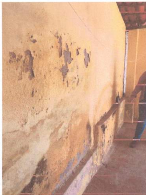
Figura 6 – Parede com unidade aparente
