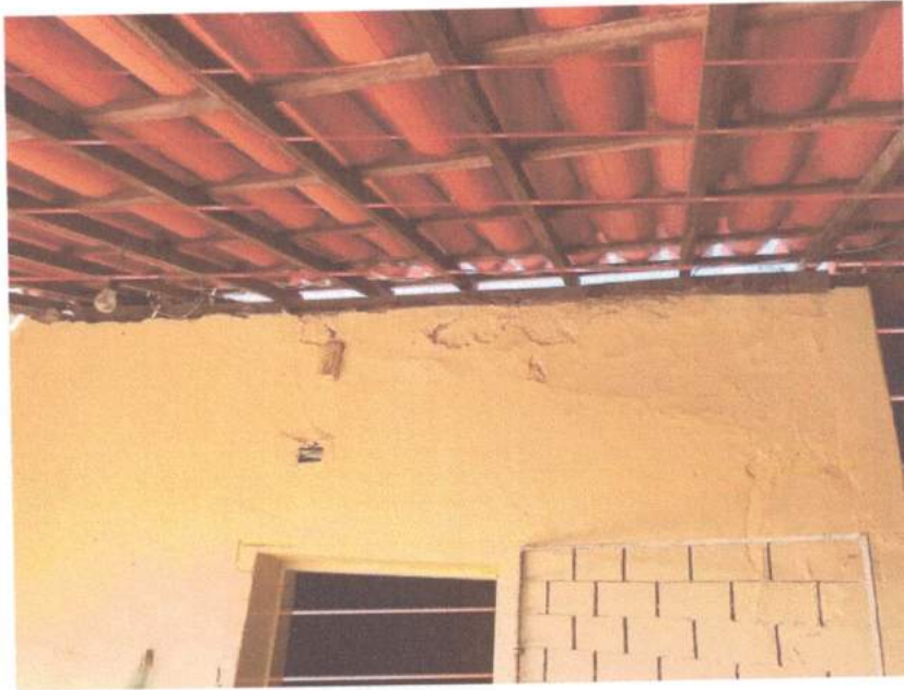
Figura 3 – Caibros e ripas apoiadas
