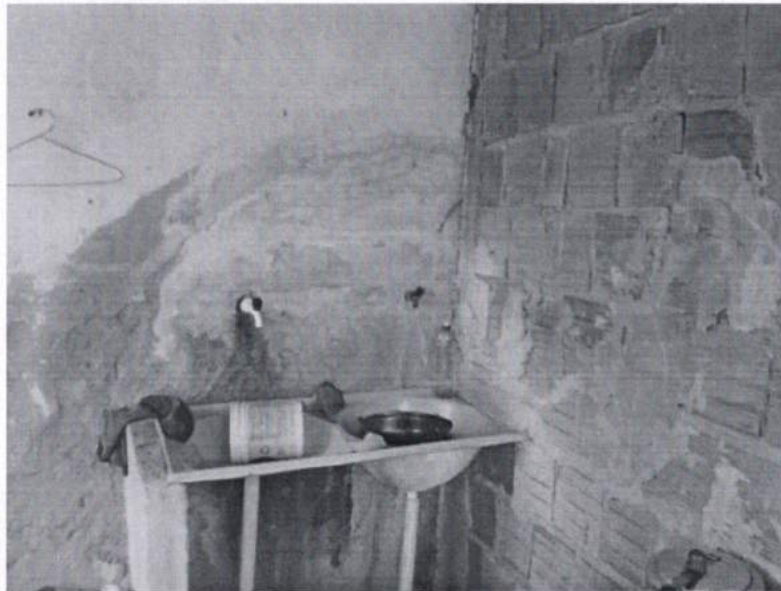
Figura 4 - Parede da área de serviço em degradação
