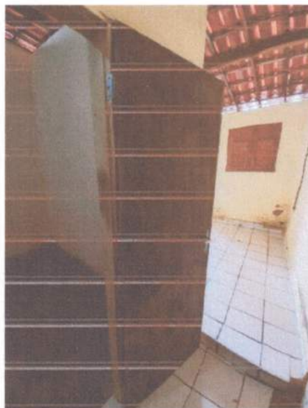
Figura 7 - Cimento queimado nos dormitórios
