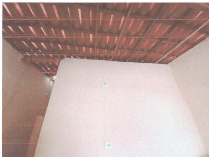
Figura 9 - Ponto de iluminação
