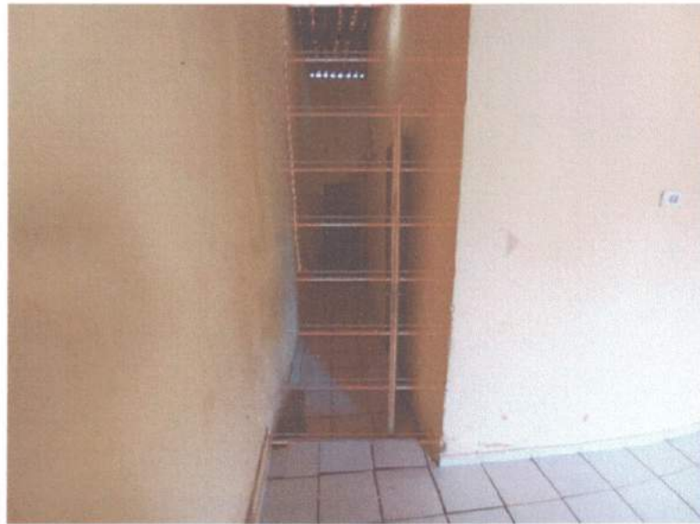
Figura 6 – piso cerâmico sala principal e corredor
