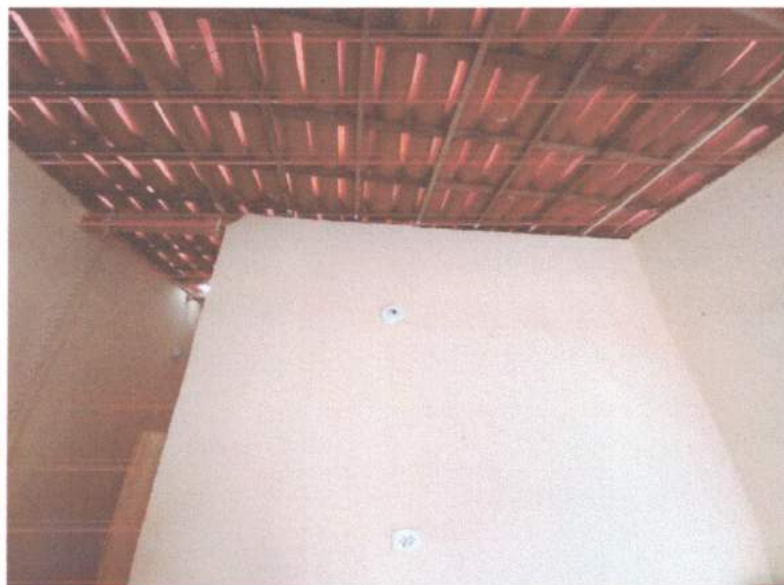
Figura 3- Caibros e ripas apoiados nas paredes
