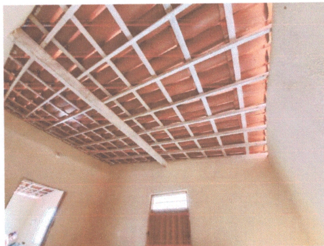
Figura 2 - Caibros e ripas apoiados nas paredes
