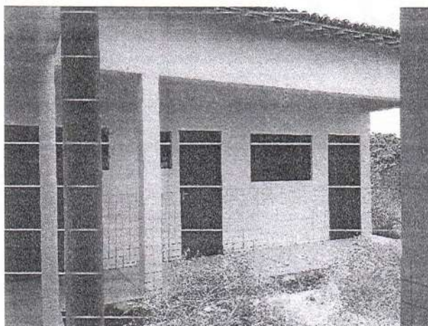
Figura 33 - Portas PM 05 sem puxador metálico
