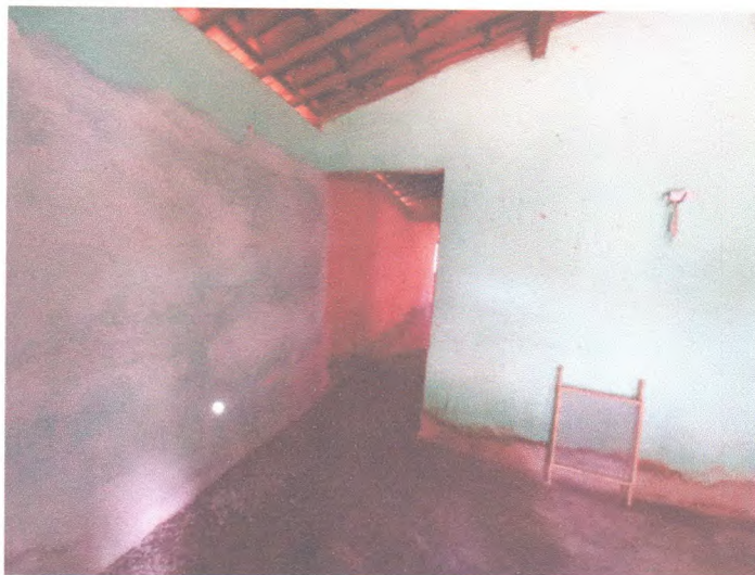
Figura 7 - Revestimento da sala
