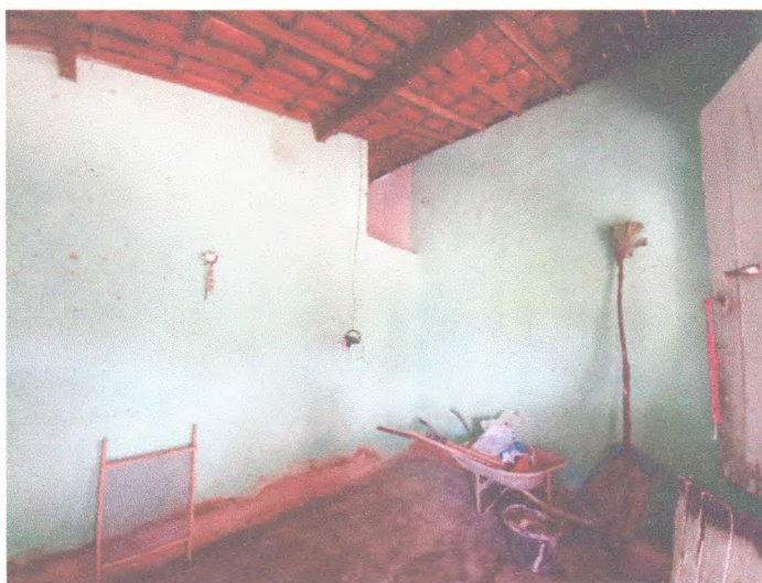
Figura 2 – Madeiramento em bom estado
