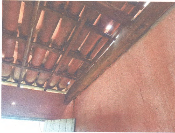
Figura 3 – Caibros e ripas apoiados nas paredes
