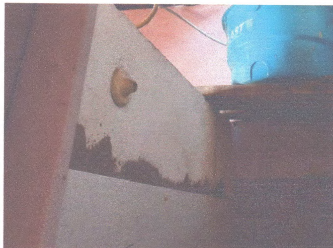
Figura 10 – Pontos de iluminação com soquete E27
