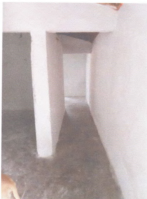
Figura 5 – Revestimento das paredes
