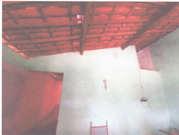
Figura 4 – Caibros e ripas apoiados nas paredes
