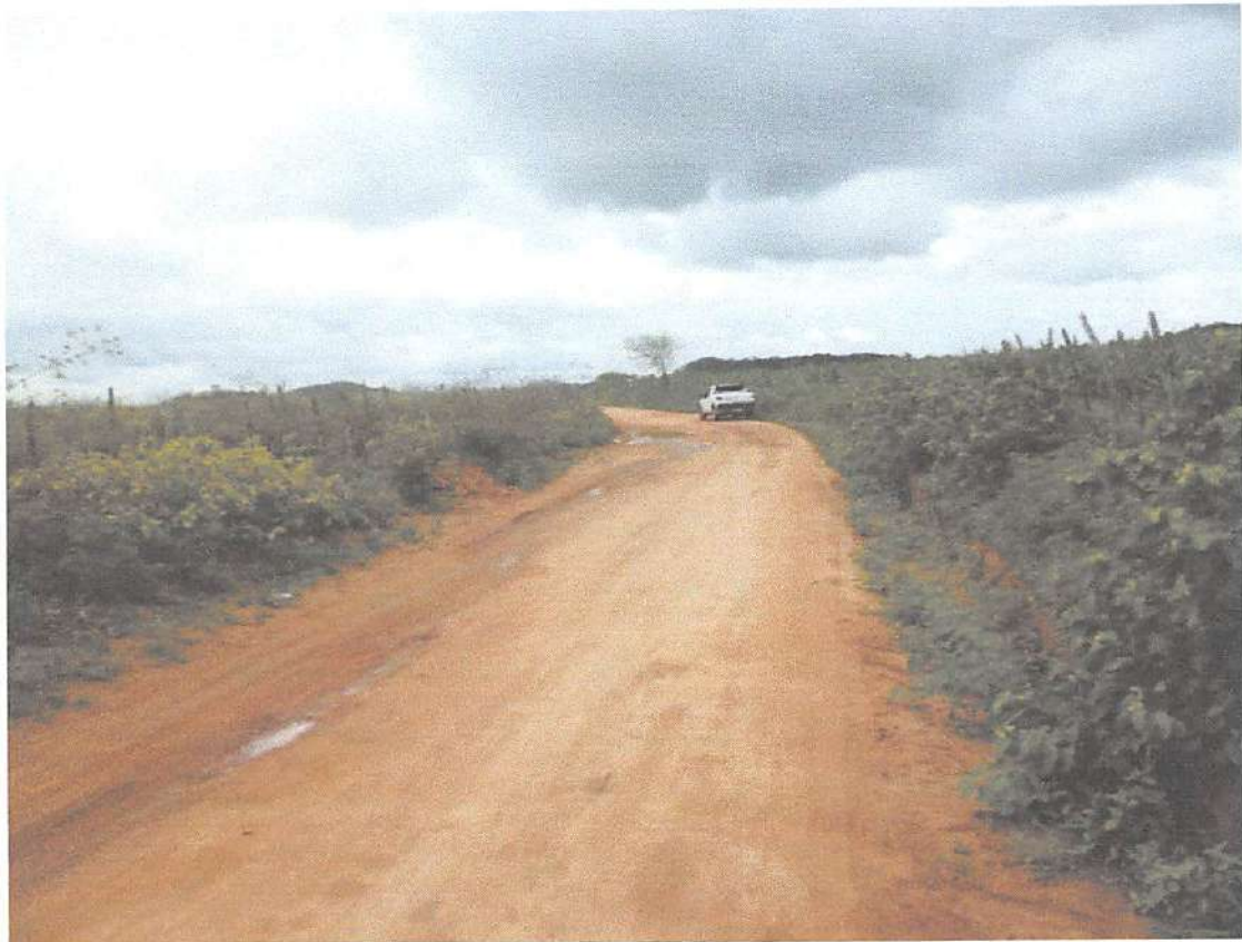
Foto 25: Estaca 270+5,00m Projeção de Bueiro 1.000 mm.
