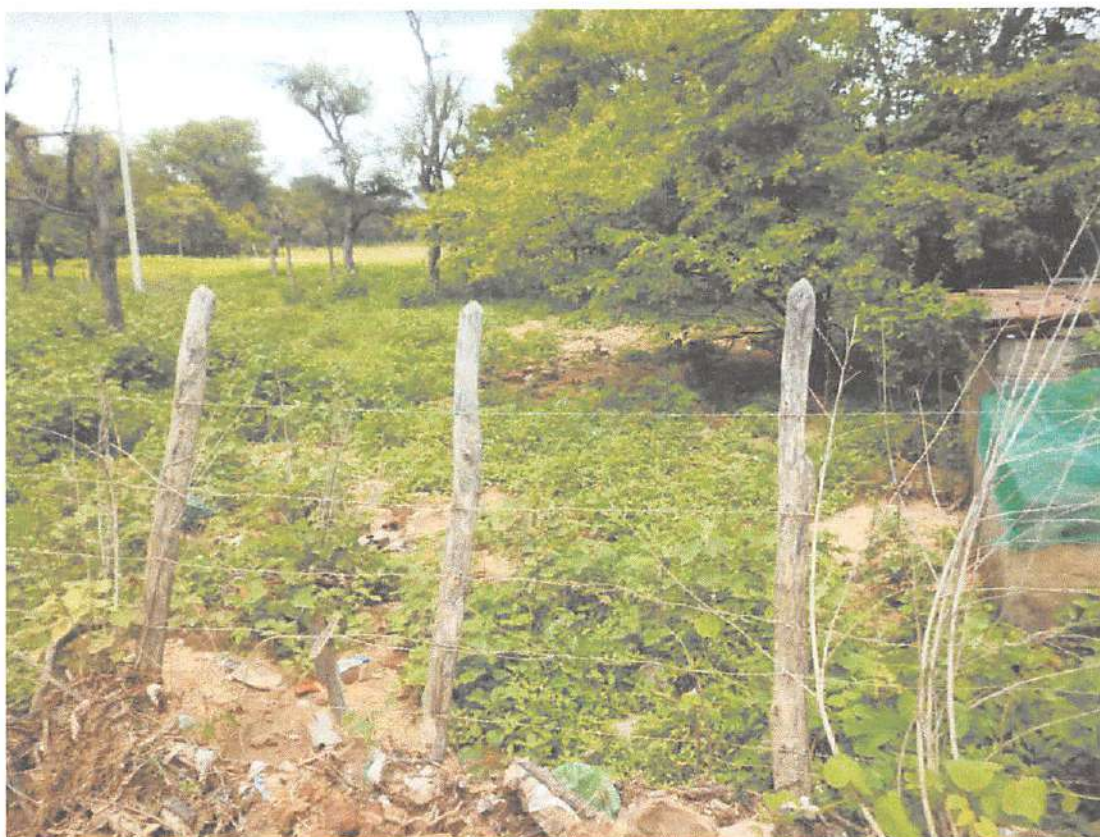
Foto 33: Estaca 362 Projeção Bueiro 1.000 mm.
