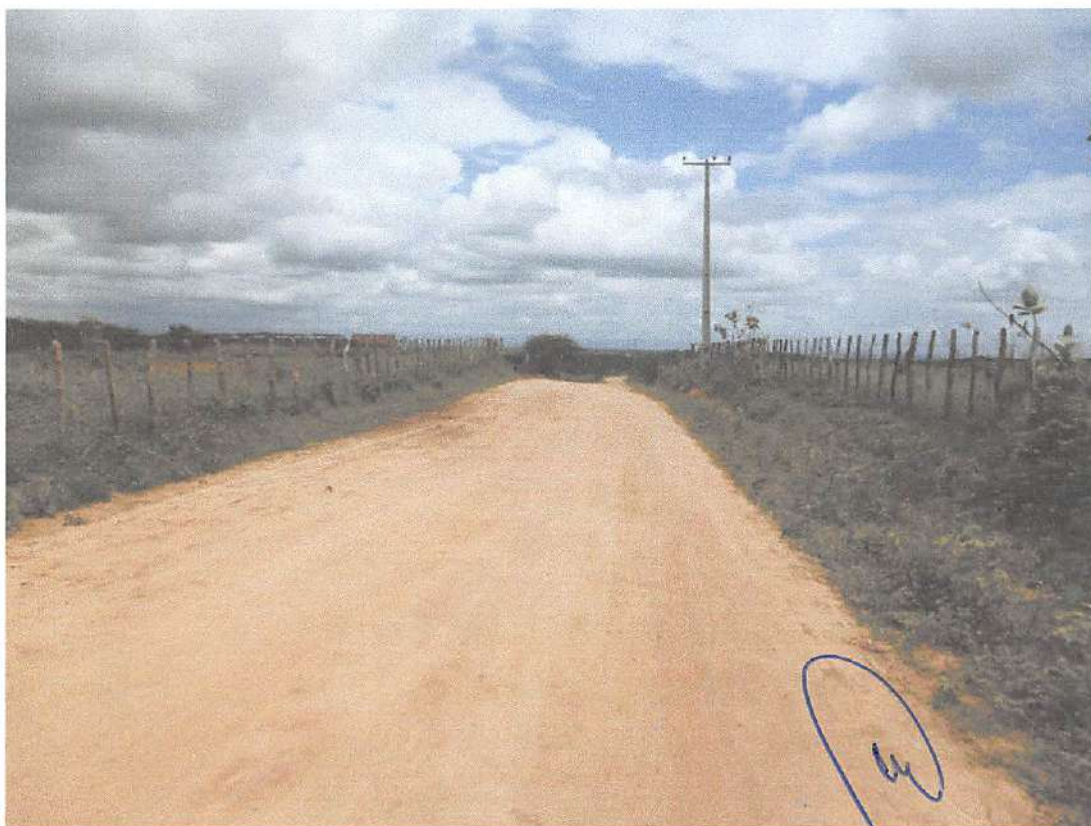
Foto 36: Estada 433, Projeção de bueiro 1.000 mm.
