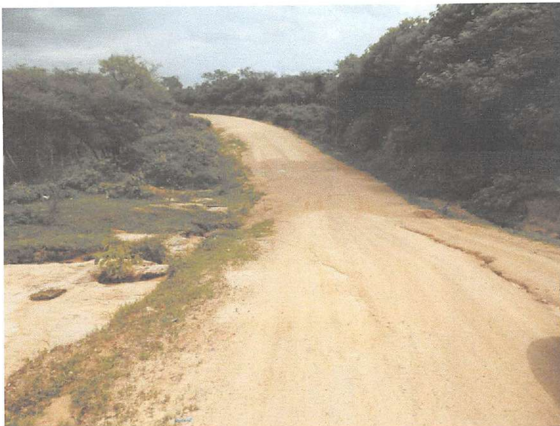
Foto 27: Estaca 298+10m Parede do Açude Existente.
