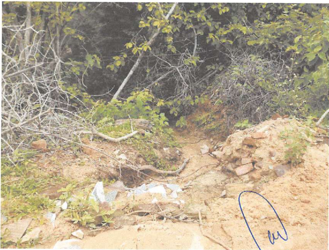
Foto 42: Final do trecho estaca 472 no Sítio Boa Esperança tendo com referência o Calçamento existente.
