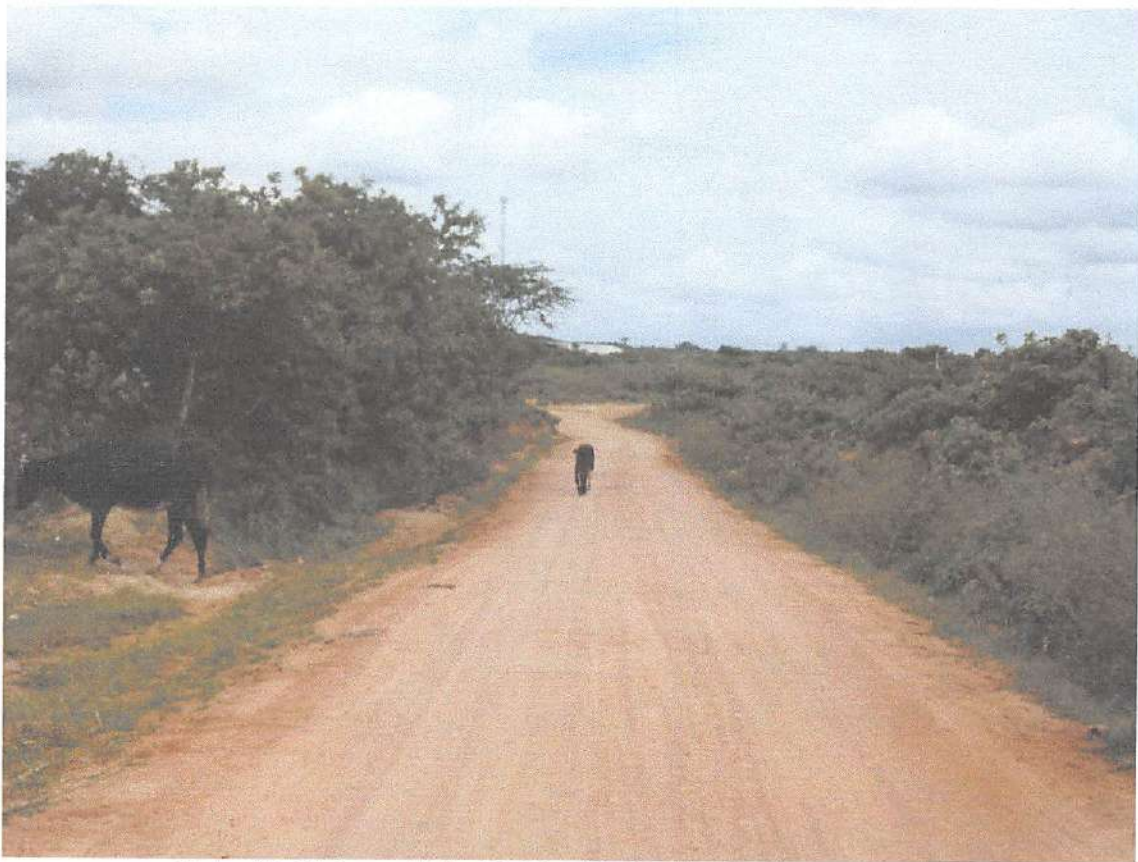
Foto 41: Estaca 455+10,00m Projeção Bueiro 1.000 mm.
