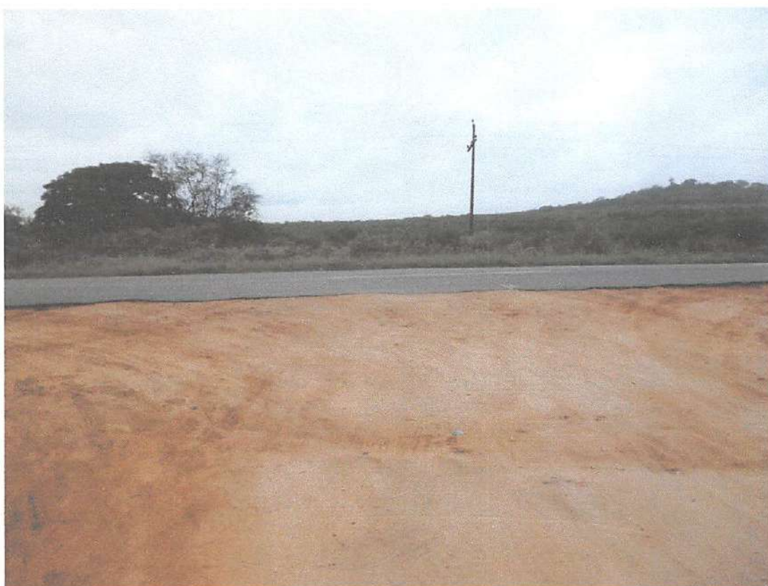
Foto 04: Início da Estrada para Localidade de Sabonete / Boa Esperança.
