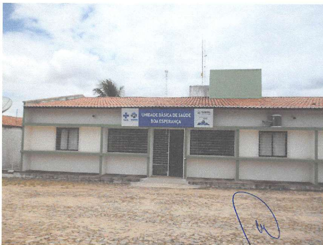
Foto 46: Estada 472, Final de Trecho perfazendo uma distância Línea de 9.440,00 metros.
