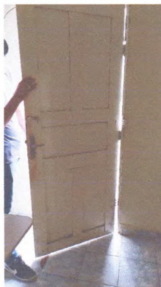
Figura 4 – Porta que dá acesso a Cozinha
