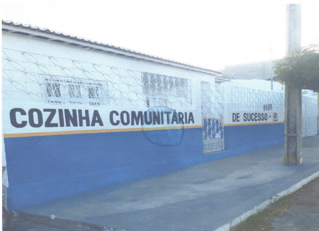
LAUDO TÉCNICO - PRÉDIO DA COZINHA COMUNITÁRIA DO DISTRITO DE SUCESSO - TAMBORIL/CE
