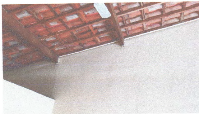
Figura 7 – Espaço para entrada de água entre o telhado e a parede
