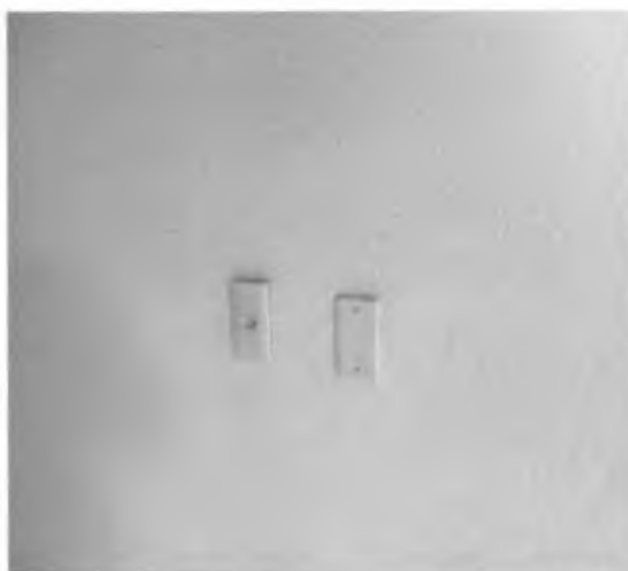
Figura 11 – Tampa cega e tomada
