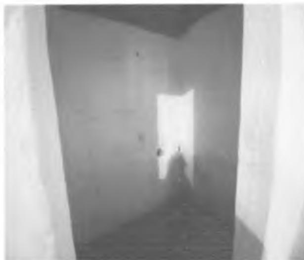
Figura 8 - Revestimento cômodo três
