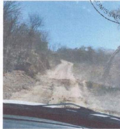
*Imagem 22: Rota 06 – Por enquanto - Tamboril– Estrada carroçável com elevação longitudinal e segregação de agregados*
