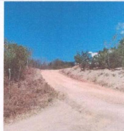
*Imagem 16: Rota 15 – Por enquanto/Açudinho – Curva acentuada com sobrelevação lateral e ganho de altitude*
