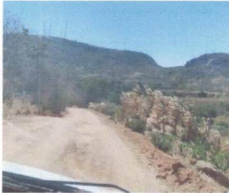
*Imagem 13: Rota 07 – Cedro/Açudinho – Estrada carroçável sinuosa, com segregação de agregados e sobrelevação transversal*
