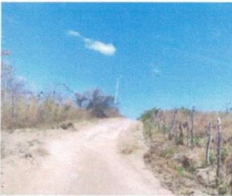
*Imagem 19: Rota 02 – Sítio dos Carlos - Tamboril- Curva com elevação transversal e longitudinais brusca e drenagem lateral inadequada*
