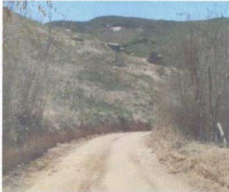
*Imagem 21: Rota 01 – Ventura - Tamboril– Curva com elevação transversal e longitudinais brusca e drenagem lateral inadequada*
