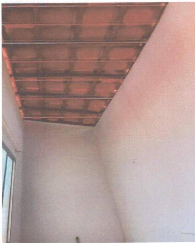
*Figura 3- Caibros e ripas apoiados nas paredes*
